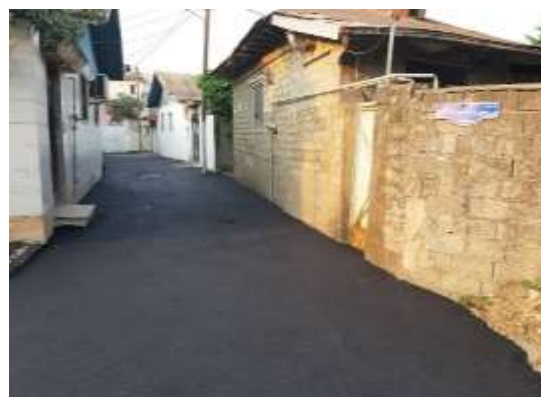
عکس بعد از اجرا
