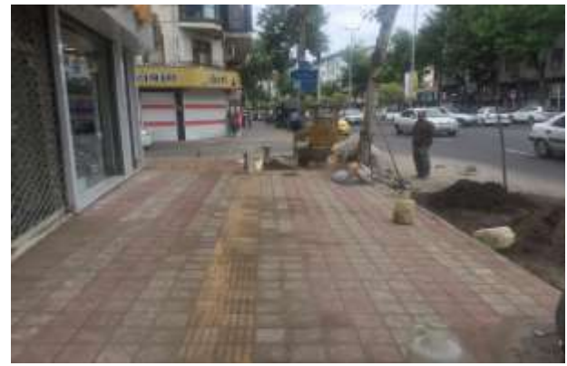
عکس بعد از اجرا
