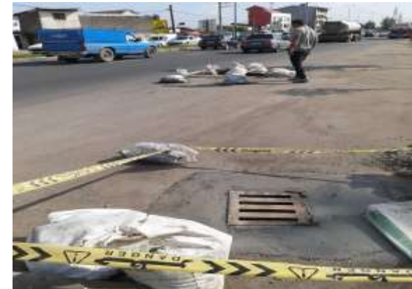
عکس بعد از اجرا
