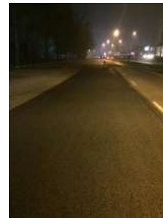
عکس بعد از اجرا
