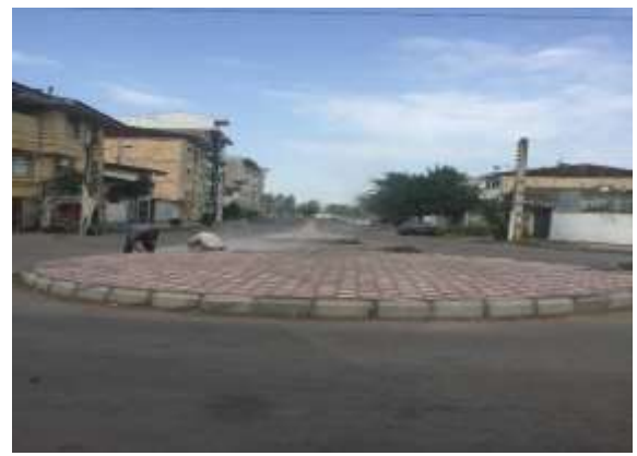
عکس بعد از اجرا
