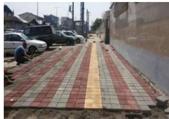
عکس بعد از اجرا
