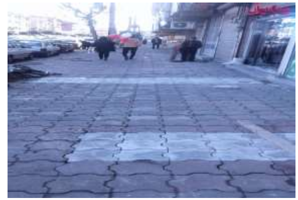
عکس بعد از اجرا
