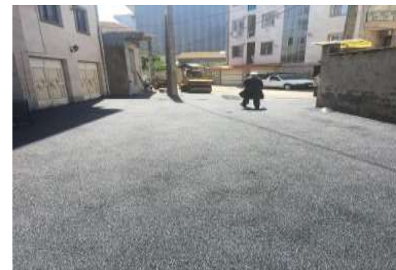
عکس بعد از اجرا
