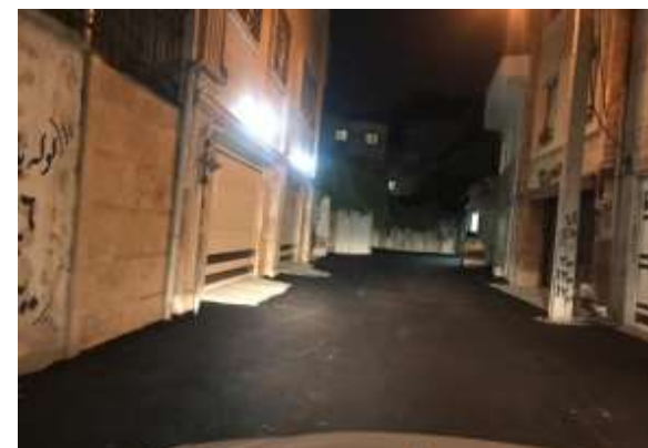
عکس بعد از اجرا
