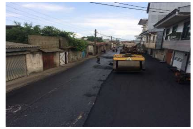
عکس بعد از اجرا
