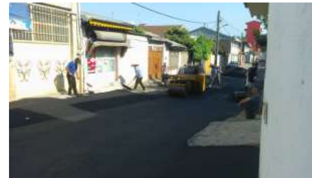
عکس بعد از اجرا
