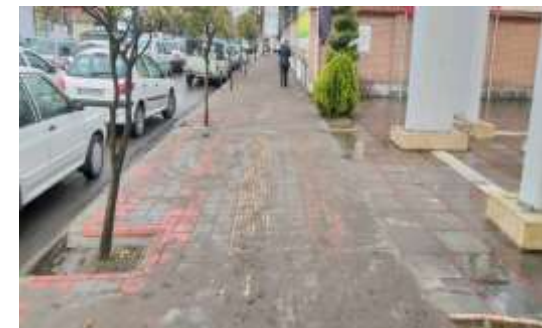
عکس بعد از اجرا
