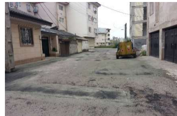
عکس بعد از اجرا
