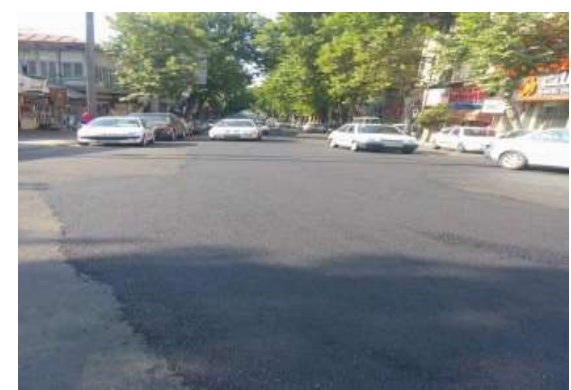
عکس بعد از اجرا
