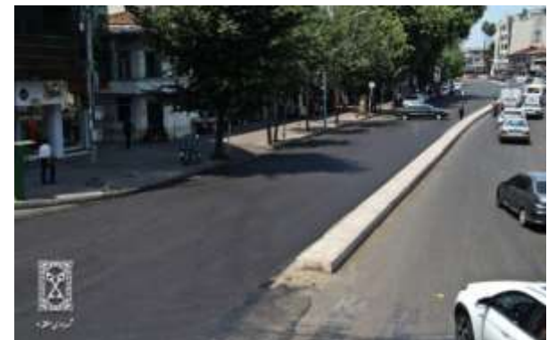
عکس بعد از اجرا
