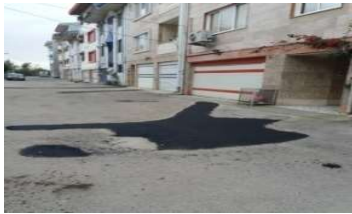
عکس بعد از اجرا
