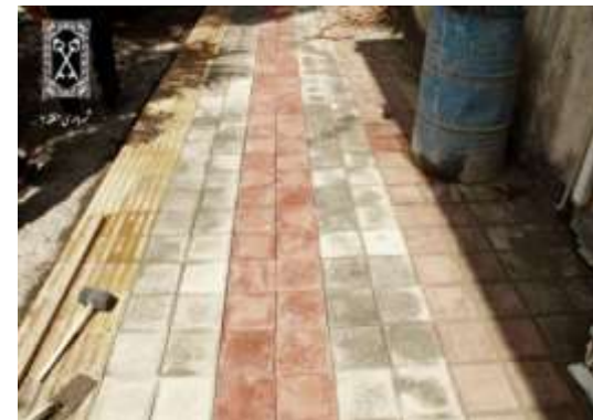
عکس بعد از اجرا
