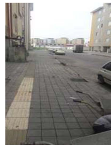
عکس بعد از اجرا
