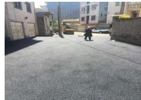
عکس بعد از اجرا
