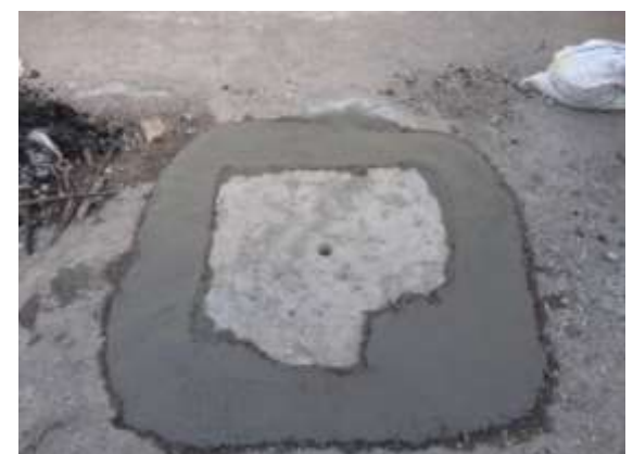
عکس بعد از اجرا
