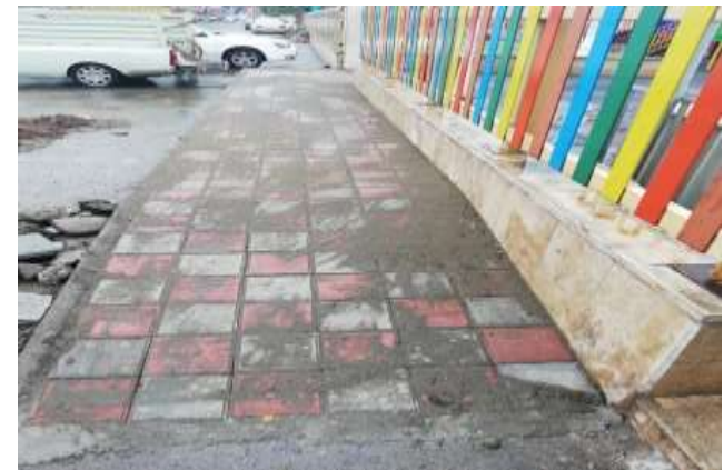
عکس بعد از اجرا
