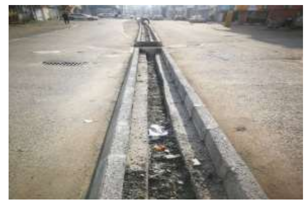
عکس بعد از اجرا
