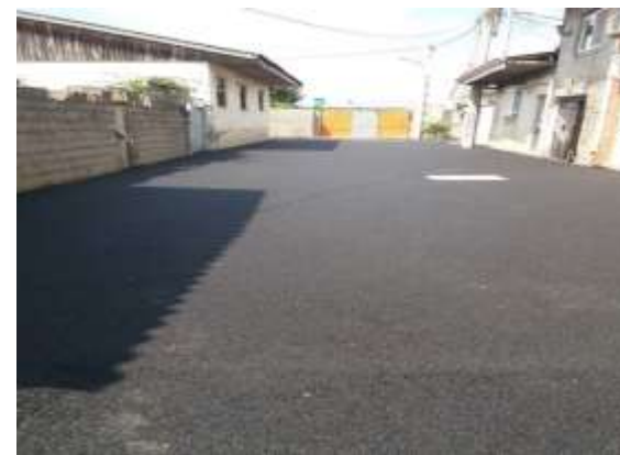
عکس بعد از اجرا
