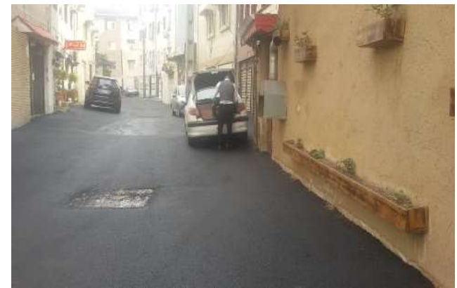
عکس بعد از اجرا
