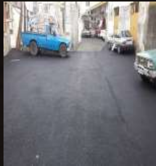
روکش خیابان بحرالعلوم- جنب ساختمان ناحیه ۱
