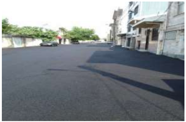
عکس بعد از اجرا
