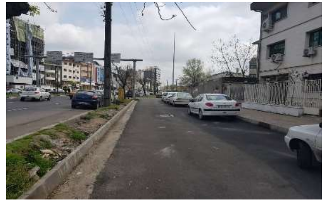
عکس بعد از اجرا
