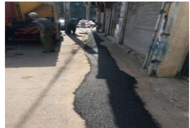
عکس بعد از اجرا
