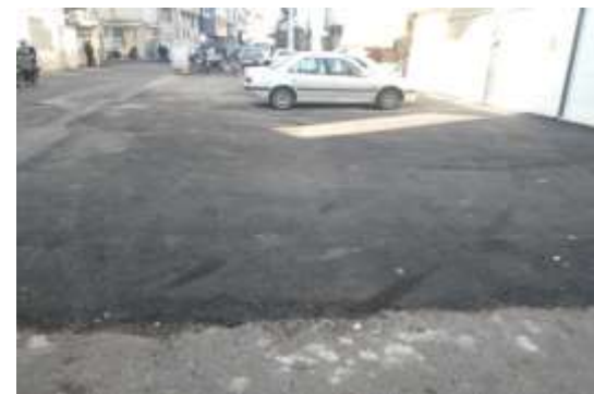
عکس بعد از اجرا
