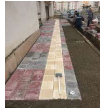
عکس بعد از اجرا
