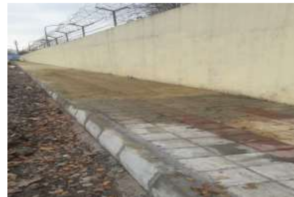
عکس بعد از اجرا
