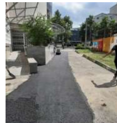
عکس بعد از اجرا
