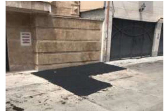
عکس بعد از اجرا
