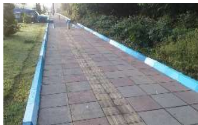
عکس بعد از اجرا
