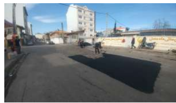
عکس بعد از اجرا
