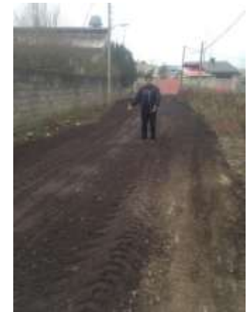
عکس بعد از اجرا
