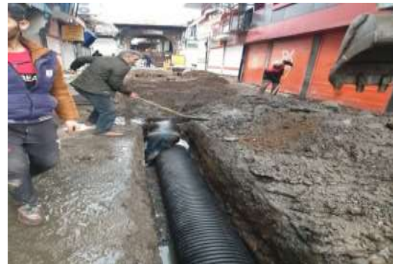
عکس بعد از اجرا
