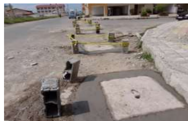
عکس بعد از اجرا
