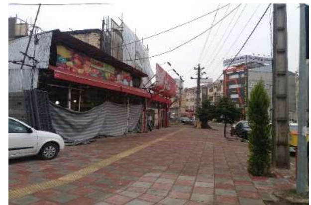
عکس بعد از اجرا
