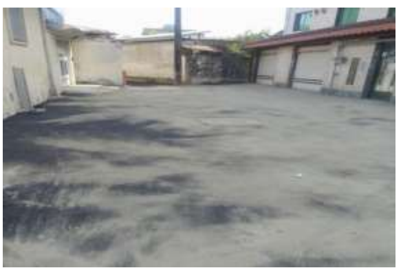
عکس بعد از اجرا
