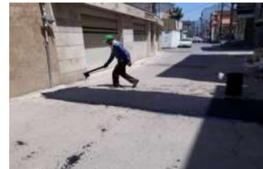
عکس بعد از اجرا
