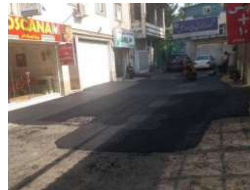
عکس بعد از اجرا
