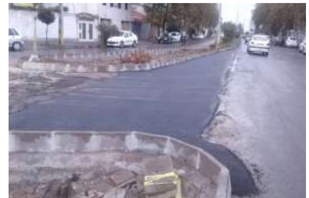
عکس بعد از اجرا
