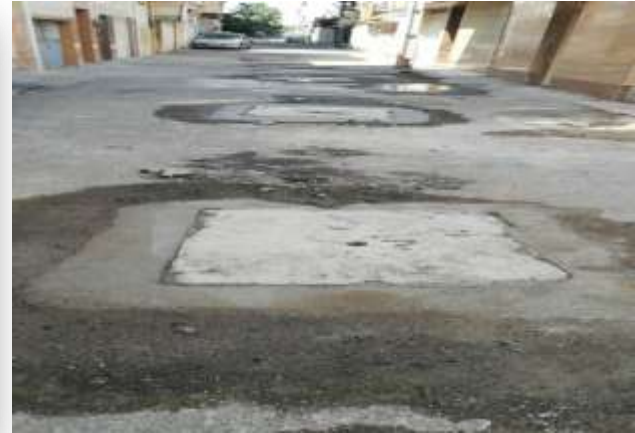
عکس بعد از اجرا
