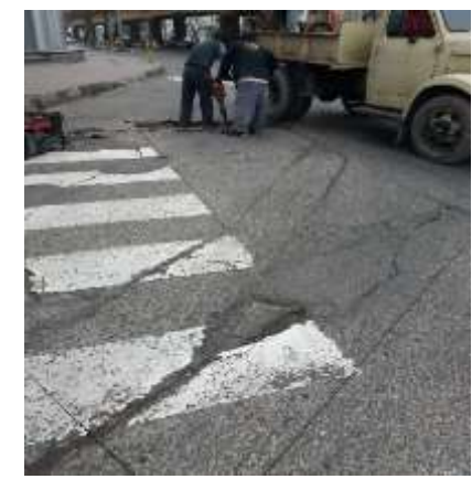
عکس بعد از اجرا
