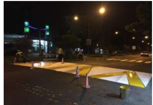
عکس بعد از اجرا
