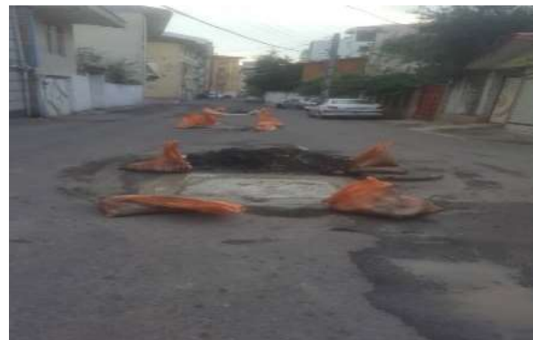
عکس بعد از اجرا
