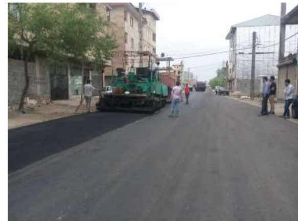
عکس بعد از اجرا
