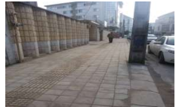
عکس بعد از اجرا
