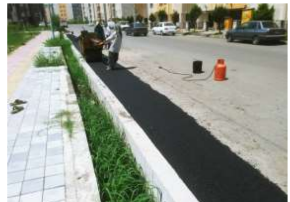
عکس بعد از اجرا
