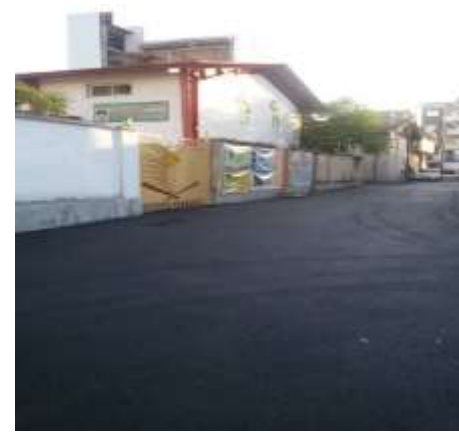
عکس بعد از اجرا
