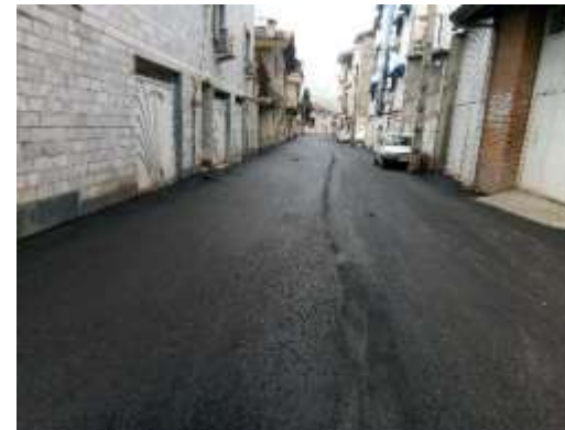
عکس بعد از اجرا
