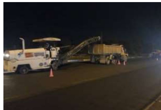
عکس بعد از اجرا
