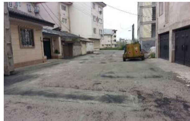
عکس بعد از اجرا
