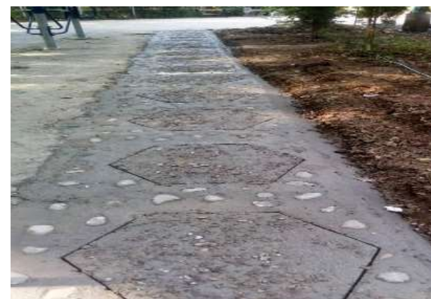
عکس بعد از اجرا
