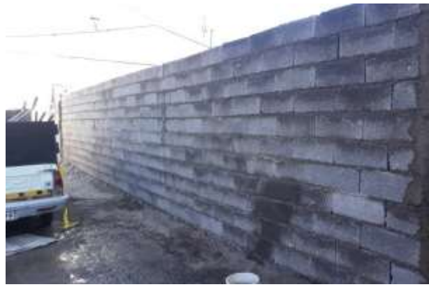
عکس بعد از اجرا
