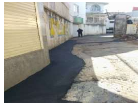
عکس بعد از اجرا
