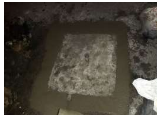
عکس بعد از اجرا
