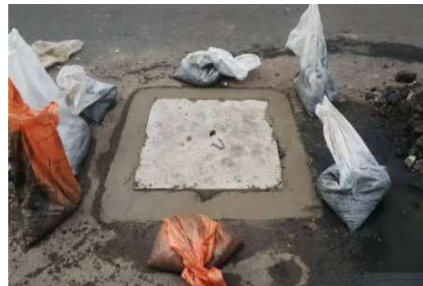
عکس بعد از اجرا
