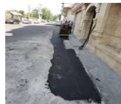
عکس بعد از اجرا
