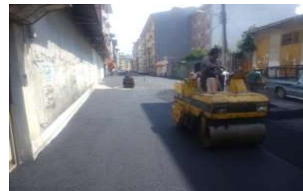
عکس بعد از اجرا
