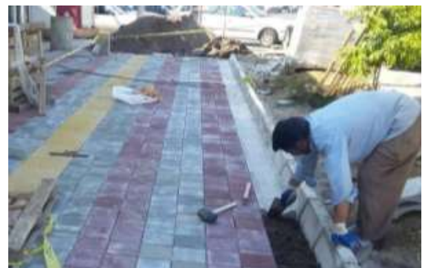
عکس بعد از اجرا
