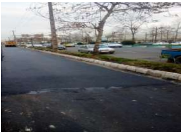
عکس بعد از اجرا
