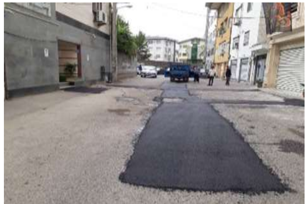
عکس بعد از اجرا
