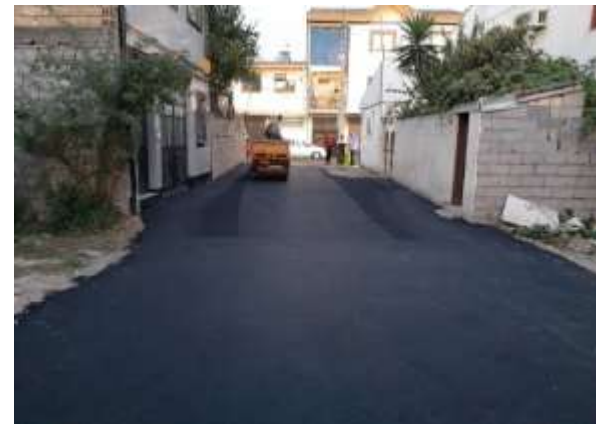
عکس بعد از اجرا
