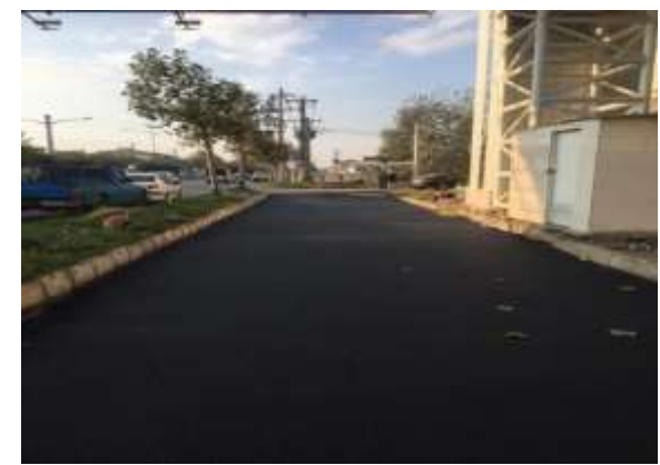
عکس بعد از اجرا
