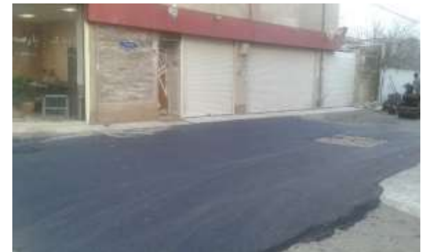
عکس بعد از اجرا
