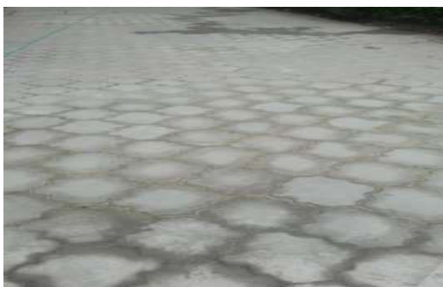
عکس بعد از اجرا
