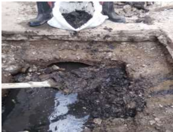
عکس قبل از اجرا
