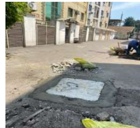
عکس بعد از اجرا
