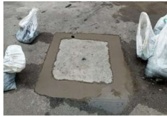
عکس بعد از اجرا
