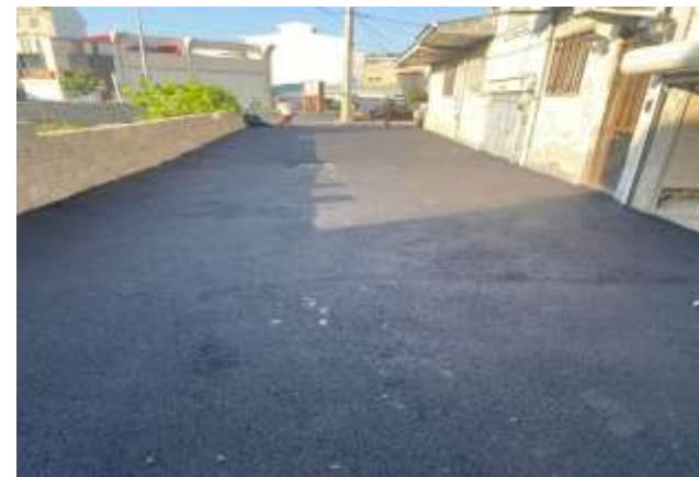
عکس بعد از اجرا
