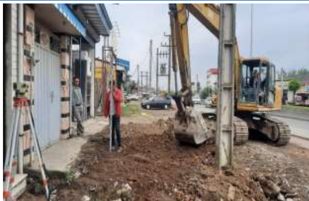
عکس قبل از اجرا
