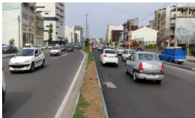
عکس قبل از اجرا
