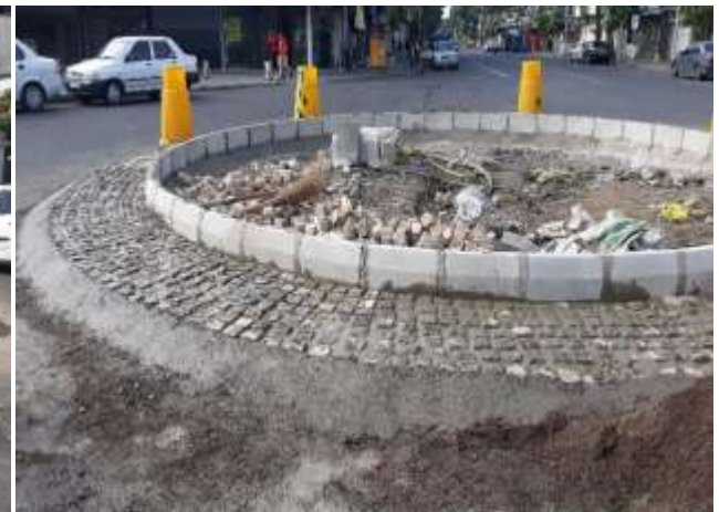
عکس بعد از اجرا
