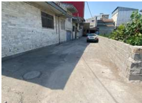
عکس قبل از اجرا
