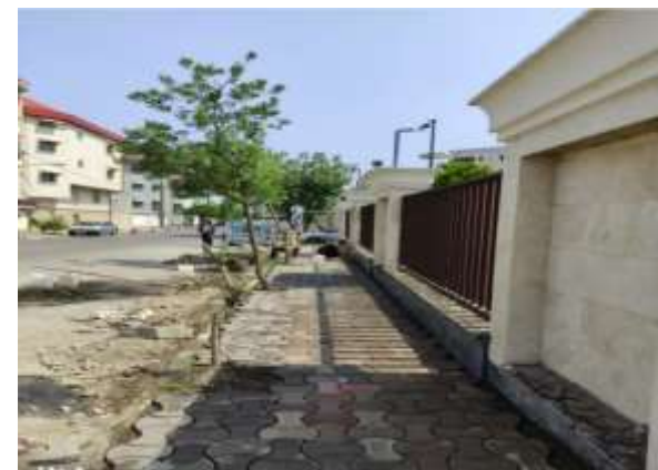
عکس بعد از اجرا
