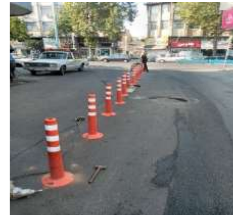
عکس بعد از اجرا
