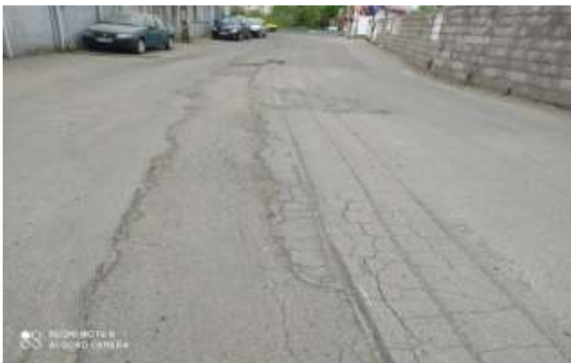
عکس قبل از اجرا
