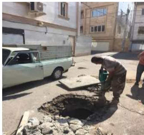
عکس قبل از اجرا
