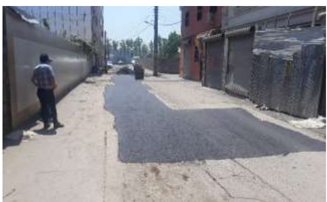
عکس بعد از اجرا
