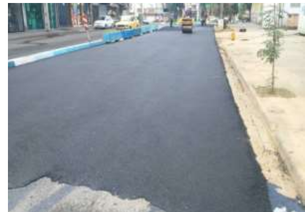
عکس بعد از اجرا
