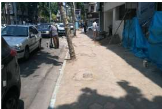
عکس قبل از اجرا
