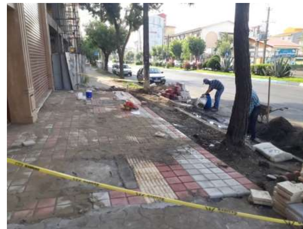
عکس بعد از اجرا
