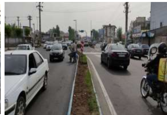
عکس بعد از اجرا
