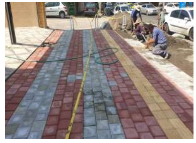
عکس بعد از اجرا
