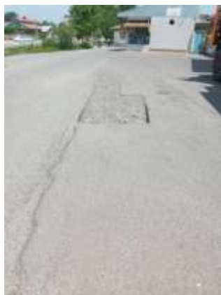
عکس قبل اجرا
