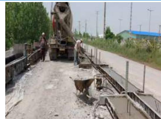
عکس بعد از اجرا
