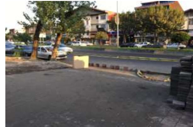
عکس بعد از اجرا
