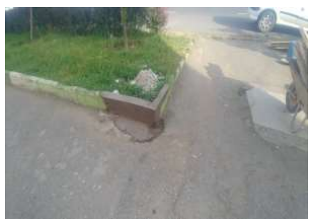
عکس بعد از اجرا
