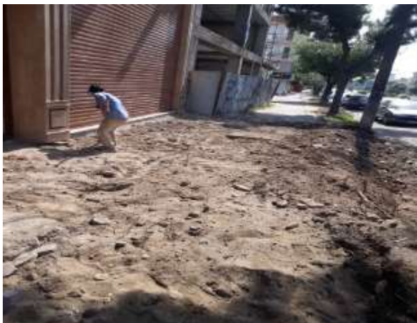
عکس قبل از اجرا
