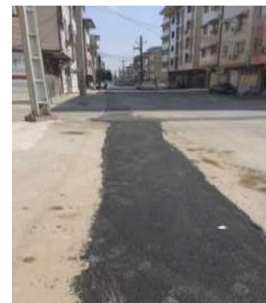
عکس بعد از اجرا
