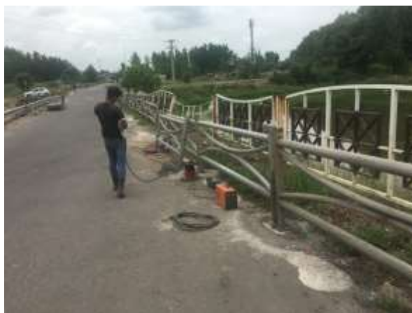
عکس قبل اجرا
