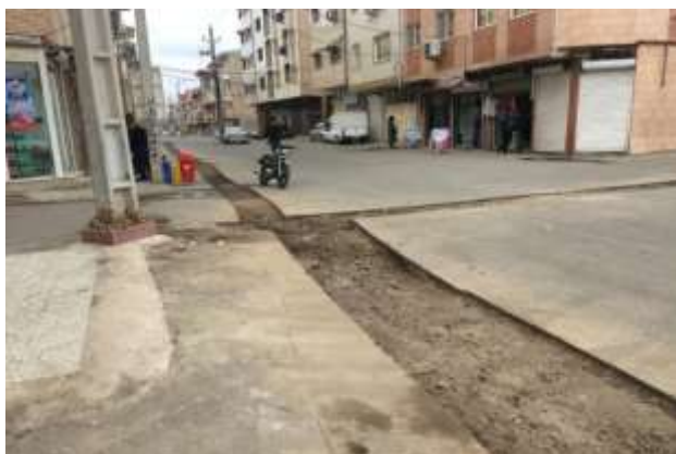
عکس قبل اجرا
