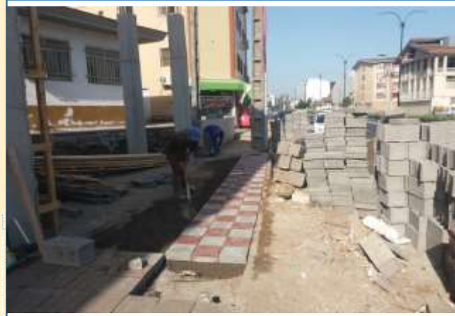
عکس قبل از اجرا
