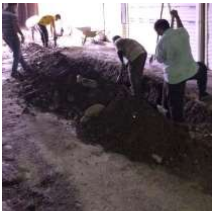
عکس قبل از اجرا
