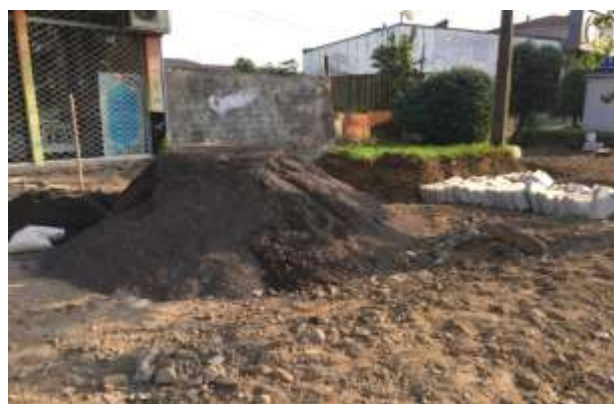
عکس قبل اجرا
