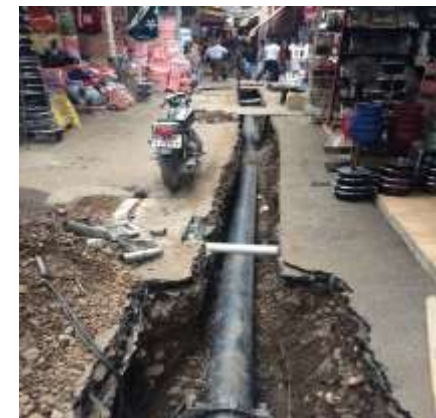
عکس بعد از اجرا
