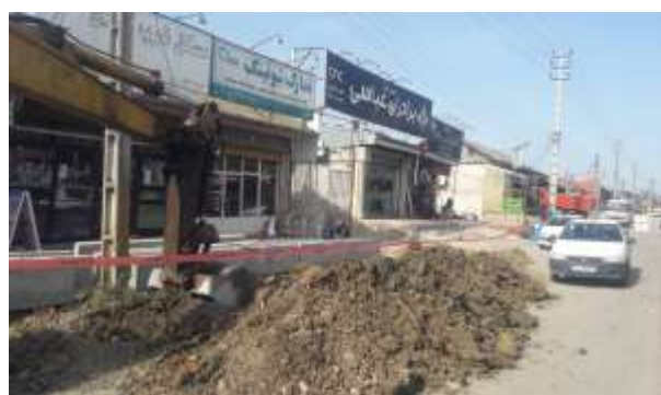
عکس قبل اجرا
