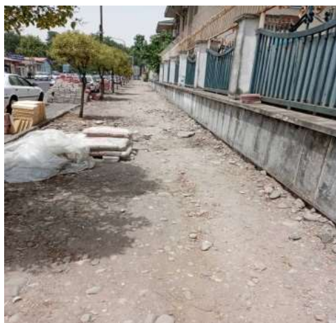
عکس قبل از اجرا
