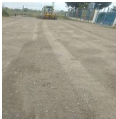
عکس قبل اجرا
