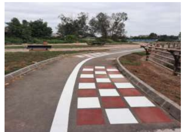
عکس بعد از اجرا
