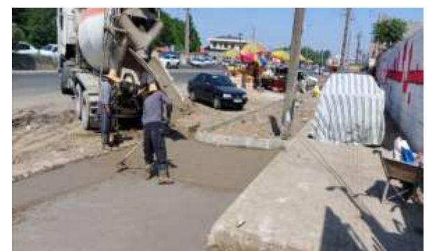
عکس بعد از اجرا
