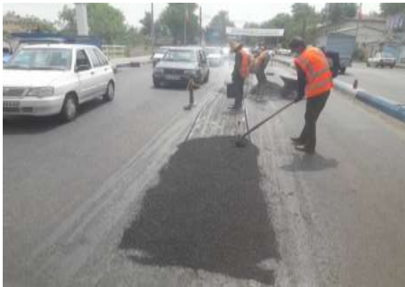
عکس قبل از اجرا
