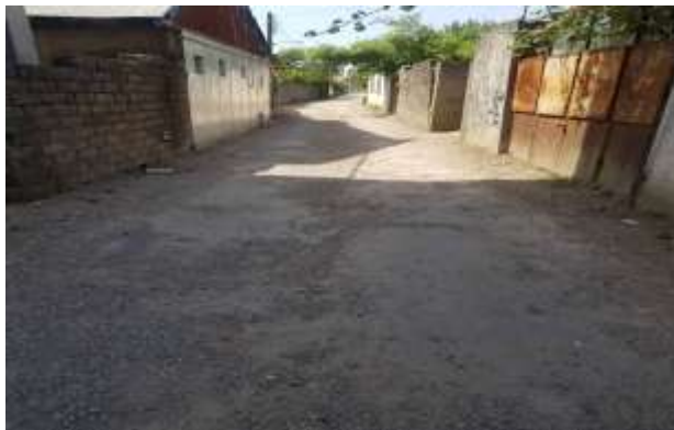
عکس قبل از اجرا
