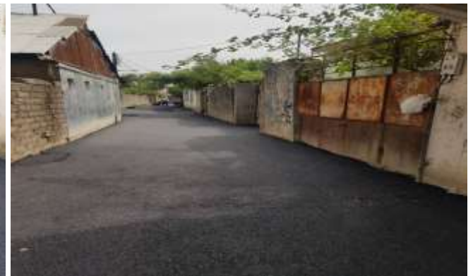
عکس بعد از اجرا
