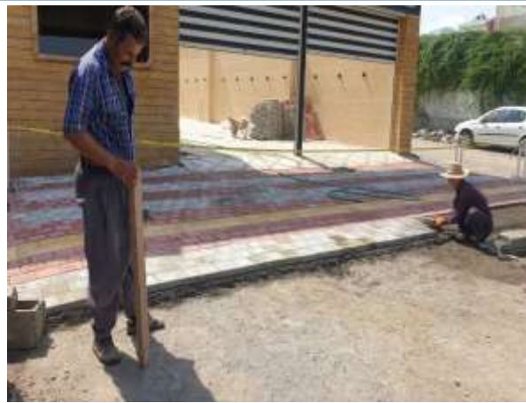
عکس قبل از اجرا
