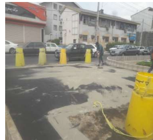
عکس بعد از اجرا
