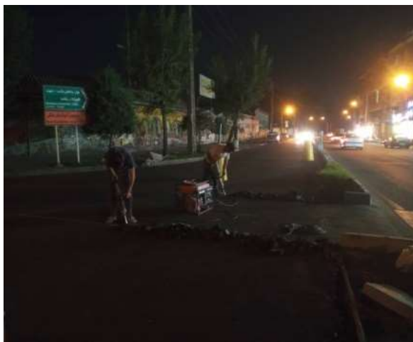
عکس قبل از اجرا
