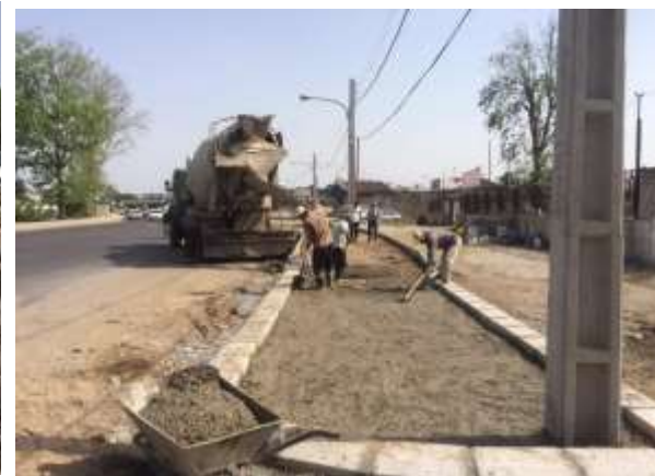
عکس بعد از اجرا
