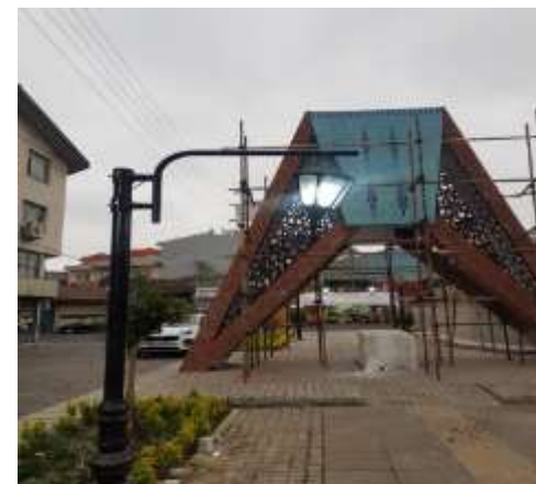
عکس بعد از اجرا
