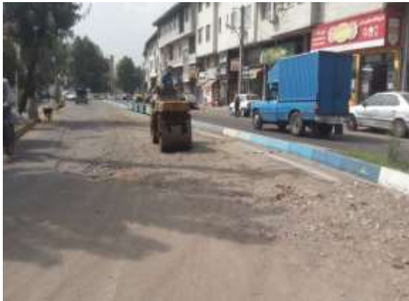
عکس قبل از اجرا
