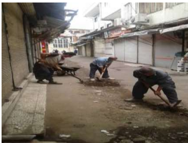
عکس قبل از اجرا
