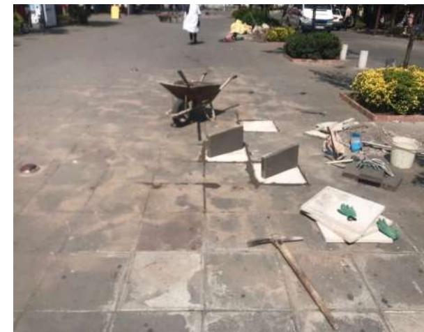
عکس بعد از اجرا
