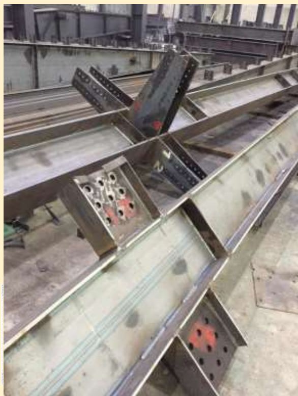
تصاویر اجرای پروژه / وضعیت کنونی
