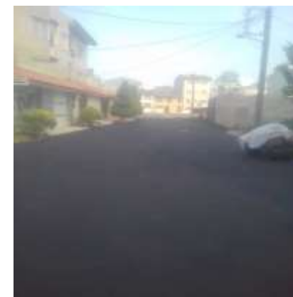
عکس بعد از اجرا
