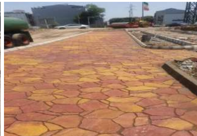
عکس بعد از اجرا
