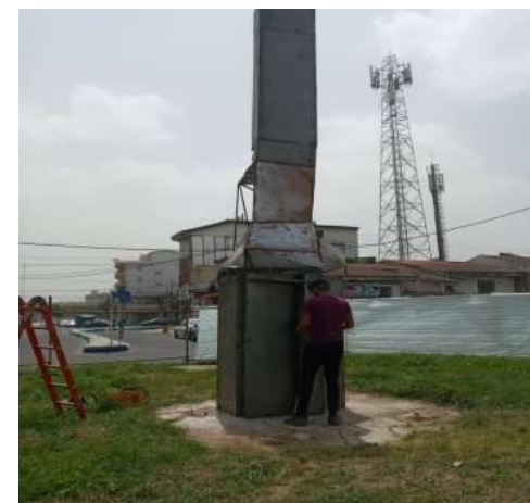
عکس بعد از اجرا
