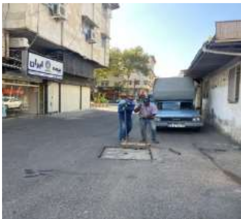
عکس قبل از اجرا
