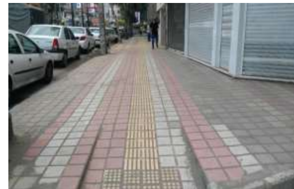
عکس بعد از اجرا
