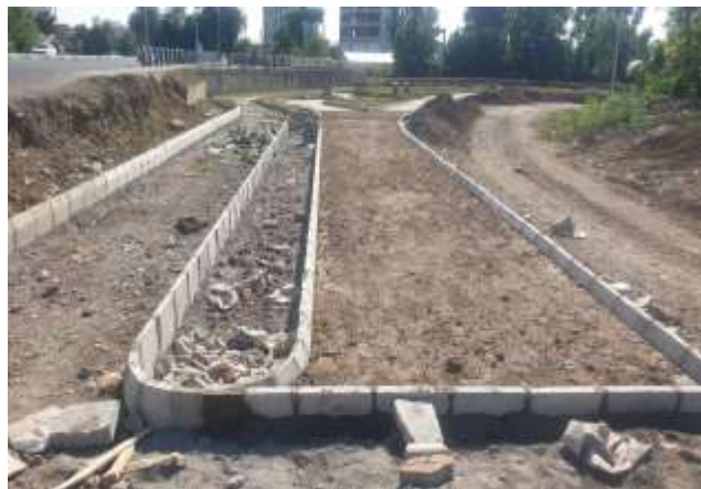
عکس قبل از اجرا
