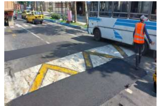
عکس بعد از اجرا
