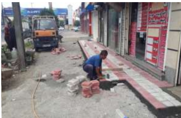
عکس قبل اجرا
