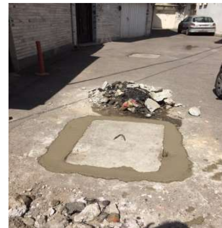
عکس بعد از اجرا
