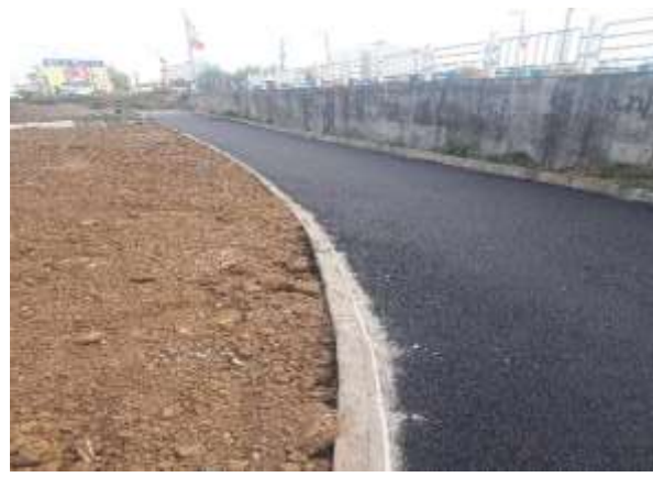
عکس قبل از اجرا
