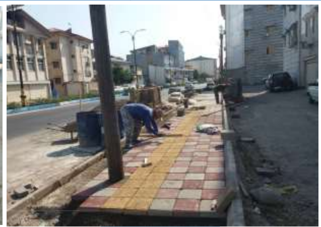
عکس بعد از اجرا
