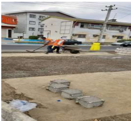
عکس قبل از اجرا
