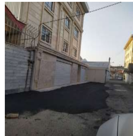
عکس بعد از اجرا
