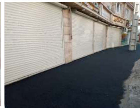
عکس بعد از اجرا
