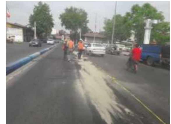
عکس بعد از اجرا
