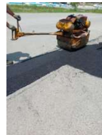
عکس بعد از اجرا
