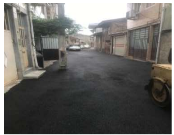
عکس بعد از اجرا
