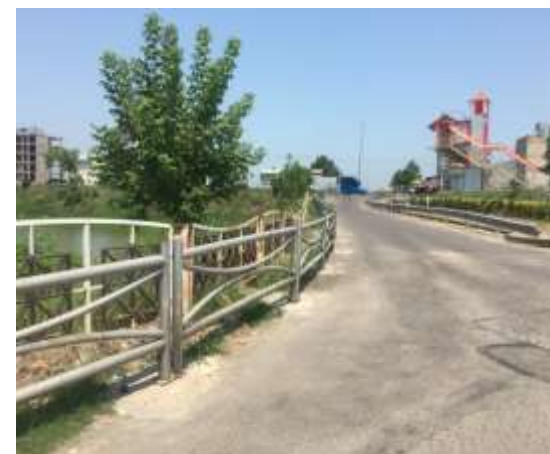
عکس بعد از اجرا
