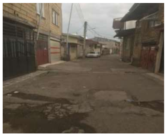
عکس قبل اجرا
