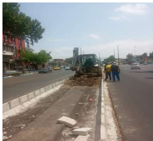
عکس قبل از اجرا
