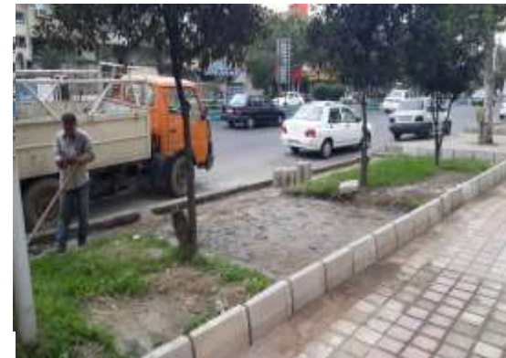
عکس بعد از اجرا
